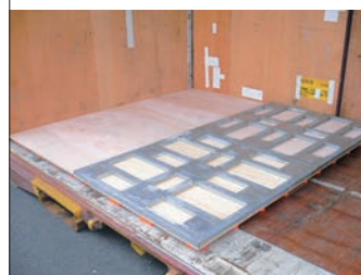
写真4 既存・フレーム防振資材設置
