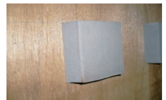
写真2 防振材(防振資材脚部)
