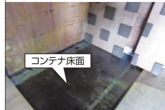
図3 コンテナの床面
