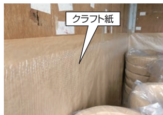
図4 電線の養生例(壁面)
