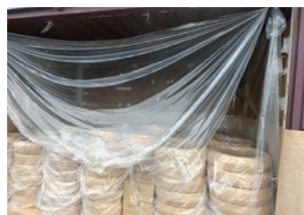
図6 電線の養生例(扉部②)
