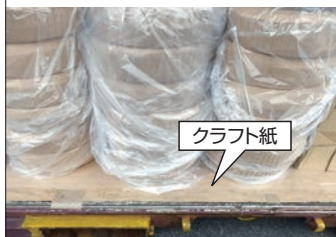
図3 電線の養生例(床面)
