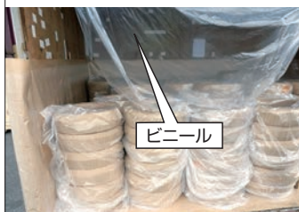
図1 電線の養生例(全体①)
