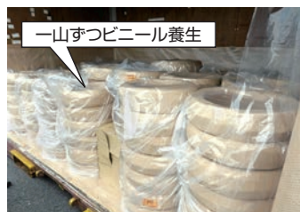
図2 電線の養生例(全体②)
